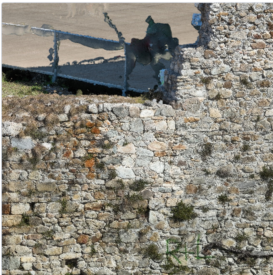
Apertura nel paramento e tessitura muraria circostante.
