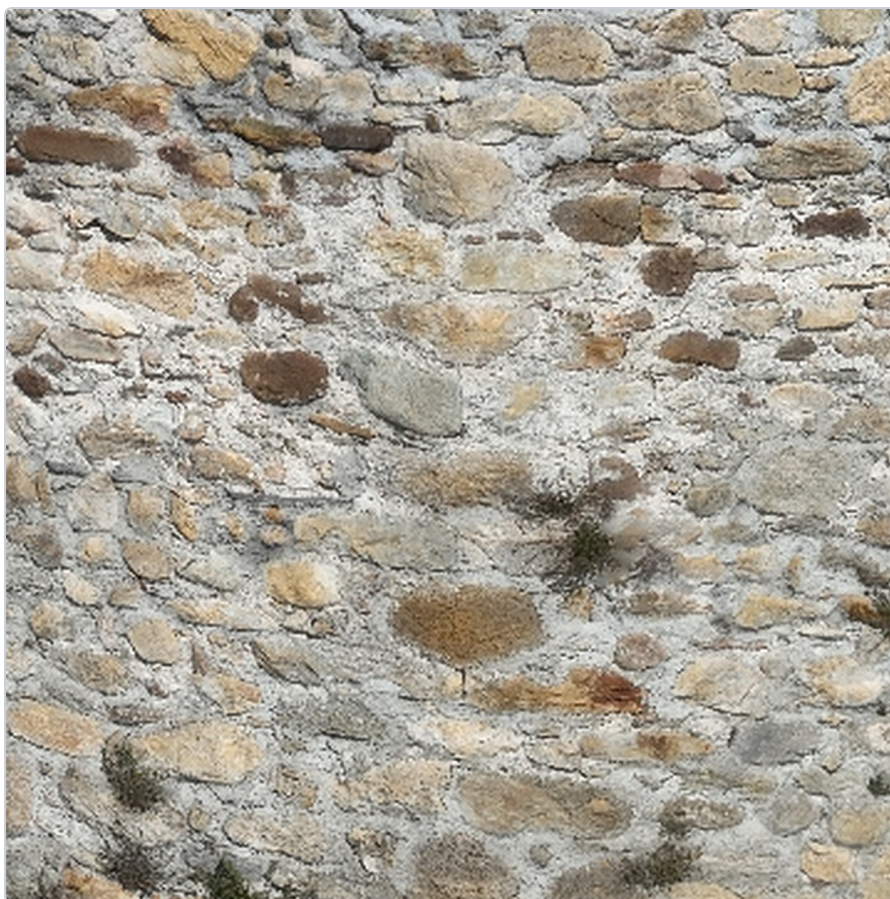
Ingrandimento sul paramento: conci e giunti di malta distinguibili.
