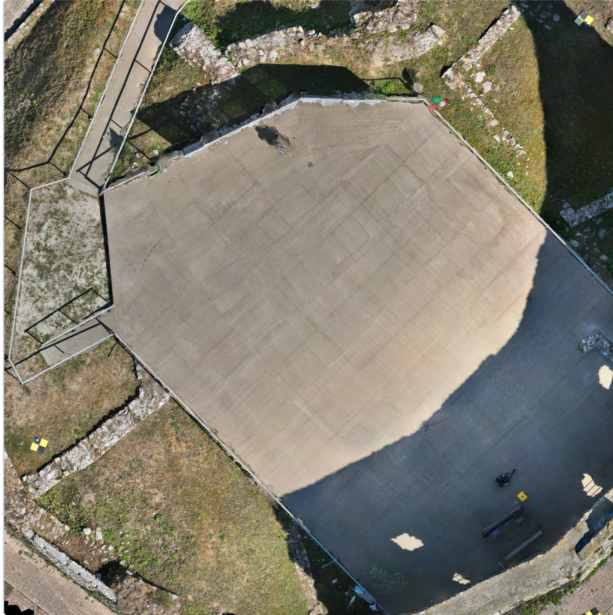
Ortofoto sul palco allestito: platea in calcestruzzo, passerelle con parapetti e sedute. Sono riconoscibili due dei quattro bersagli a scacchiera.
